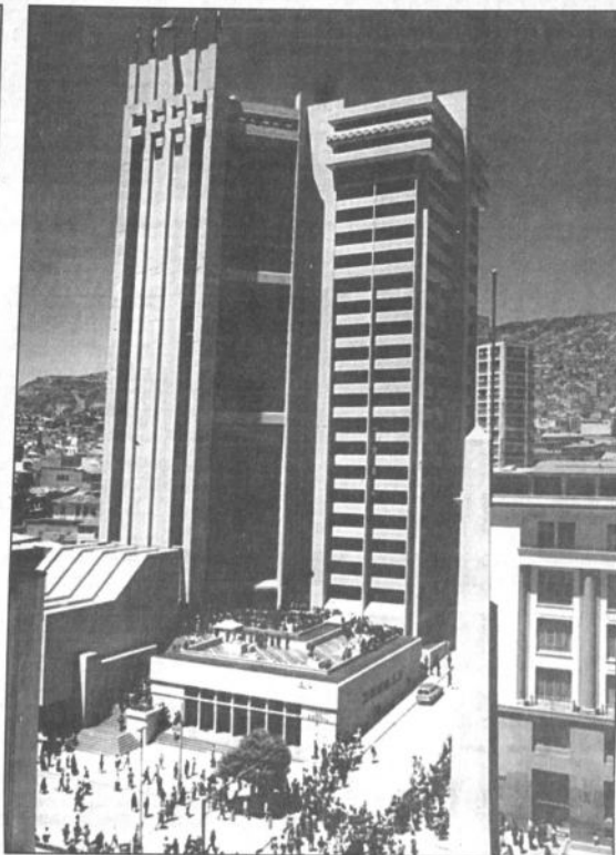
En el piso 14 del Palacio de Comunicaciones funciona la Dirección General de Telecomunicaciones, entidad sobre la cual pesan varias denuncias de irregularidades.
