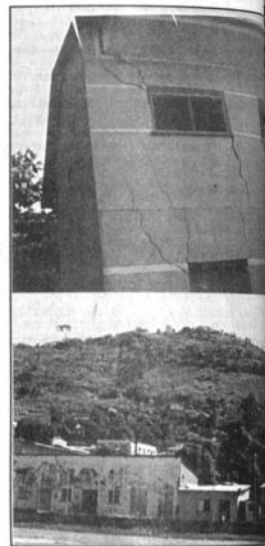
Una gran parte del cerro "Coronel" se deslizó, afectó a más de un centenar de viviendas de Guanay, en la fotografía se ven las rajaduras que se han presentado en el cerro.
