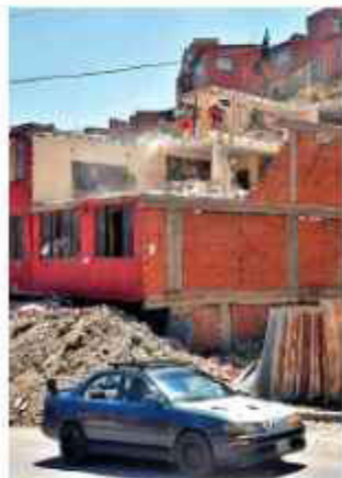
TRABAJOS. Se realizan las demoliciones de casas.
