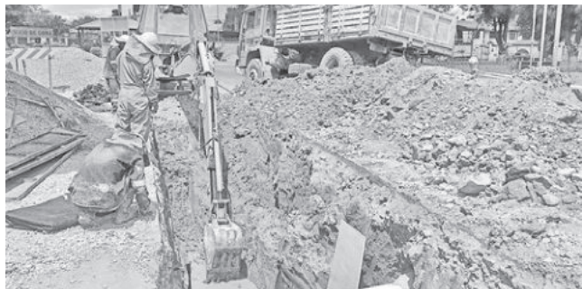
Los trabajos del colector en la av. Cabildo, ayer. CARLOS LÓPEZ
