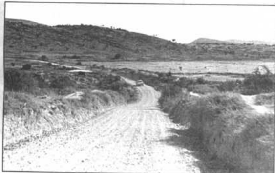
Esta carretera podrá ser rehabilitada con la donación de equipo pesado del Japón.
