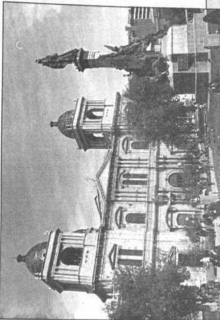
El levantamiento de las torres de la Catedral de La Paz contempló la construcción total de la estructura de hormigón armado, además de las cúpulas de cobre y las esculturas de piedra reconstituida. Esta obra fue concluida en el año 1989.
