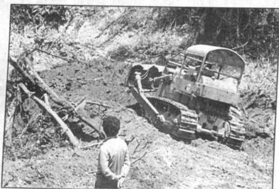
La construcción de carreteras, que es vital para lograr el desarrollo y la integración, también provoca la alteración del ecosistema por la presencia de maquinaria pesada, como muestra la presente foto.
