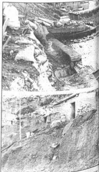
Parte de las humildes viviendas afectadas por derrumbes
