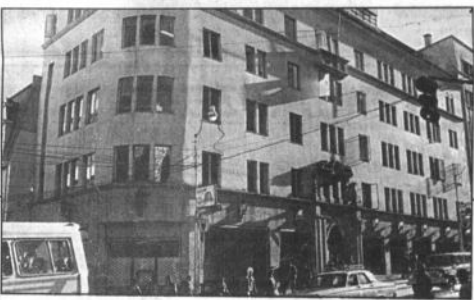
Frontis del edificio de la Corporación Minera de Bolivia, en La Paz, donde están ubicadas las oficinas de los principales ejecutivos
