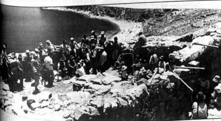
Trabajo sur de la "Chinkana" en pleno proceso de restauración.
