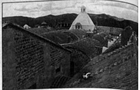
Techos coloniales en Potosí
