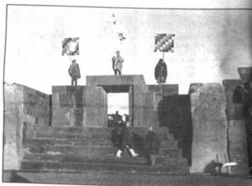
El paso de camiones de alto tonelaje perjudica la estabilidad milenarias construcciones
