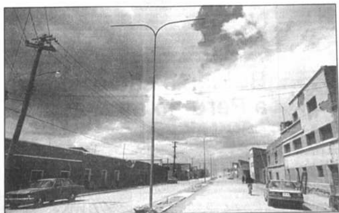
Postes para luz La avenida Brasil, en la zona sur de la ciudad de Oruro, ha adquirido visibilidad con el colocado de postes para el alumbrado público. Es de esperar que las autoridades competentes, con motivo del próximo aniversario cívico, ordenen la instalación del sistema eléctrico y las luminarias para completar la obra que está inconclusa desde hace algún tiempo.
