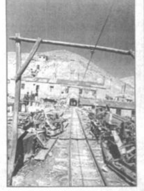
Entrada a la mina de San José
