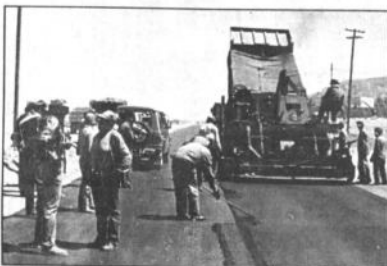
El equipo asfáltador concluye el último tramo de la carretera El Alto-Oruro.
