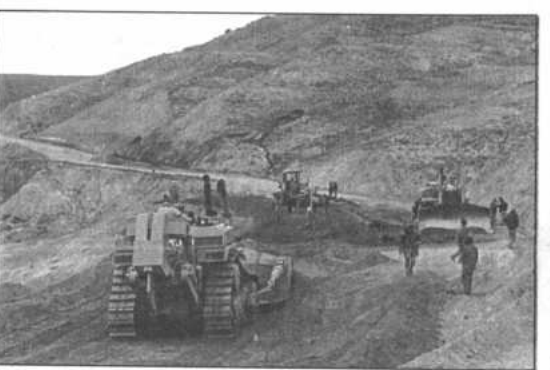
Trabajos Maquinaria pesada durante un día de trabajo. Los movimientos de tierras tienen un avance de más de 87% y se prevé su conclusión hasta mediados de enero del próximo año.
