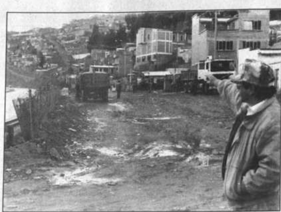
Zona del desvío en Rincón La Portada, que utilizarán temporalmente los conductores, mientras se construye el puente.
