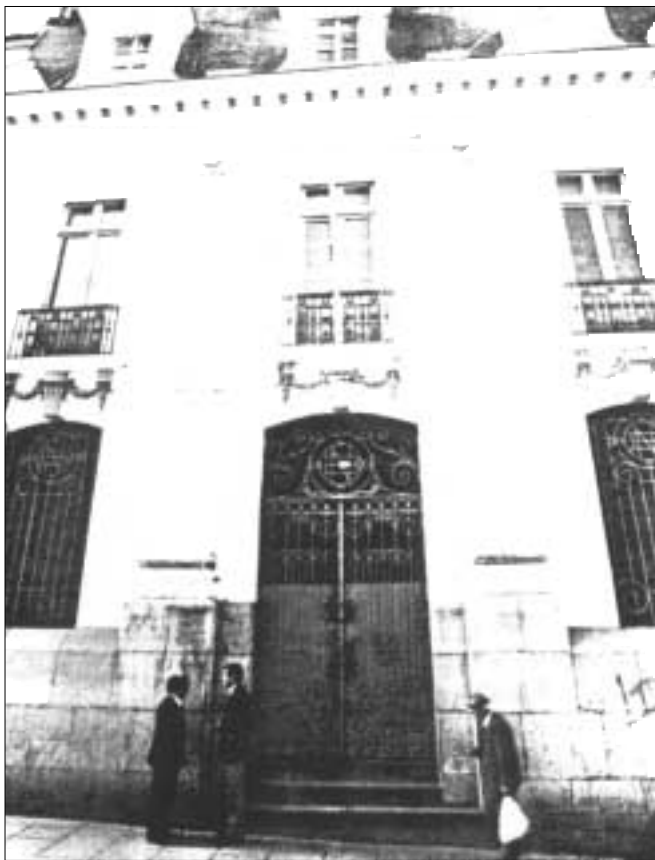
Antigua sucursal de BCB, ubicada en la calle Ingavi.
