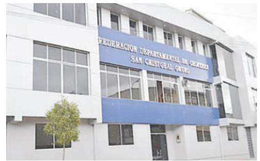
El edificio de la Federación de Chóferes San Cristóbal / LA PATRIA
