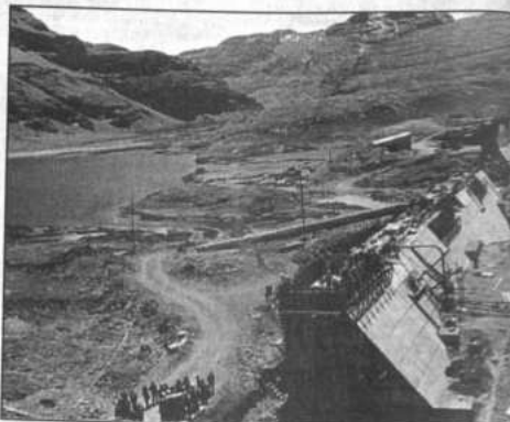
Las obras concluirán en marzo del próximo año
