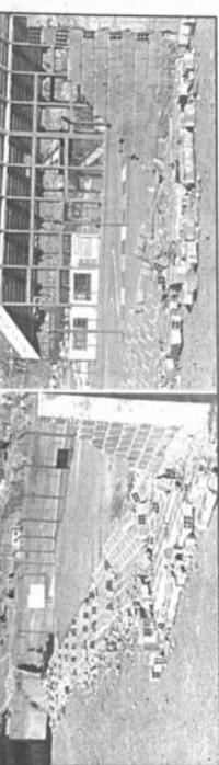
Así quedó una de las paredes de protección del velódromo de Alto Irpavi cuando un viento huracanado (de aproximadamente 45 k/h) del sábado produjo su desmoronamiento. Más o menos 3.000 ladrillos quedaron desparpamados en el piso de que tiene una longitud de más de 150 metros.
