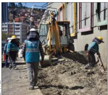
Trabajos en la avenida Costanera.
