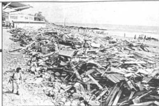
DESOLACION Y DESTRUCCION QUE DEJO EL MAREMOTO MANAGUA, NICARAGUA. Un soldado pasa frente a una monumental cantidad de escombros, al sur del barrio Cascares. El maremoto produjo daños en 50 comunidades a lo largo de la costa nicaragüense del Pacífico y dejó al menos a dieciséis mil personas sin hogar. (Foto Reuters)
