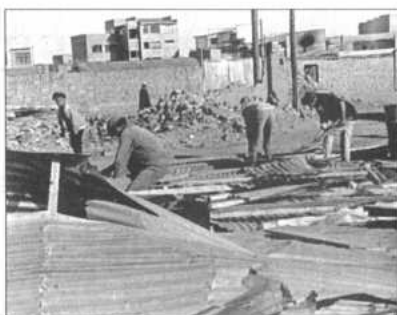
Empleados de la comuna alteña actuaron con agresividad en la demoli- ción.
