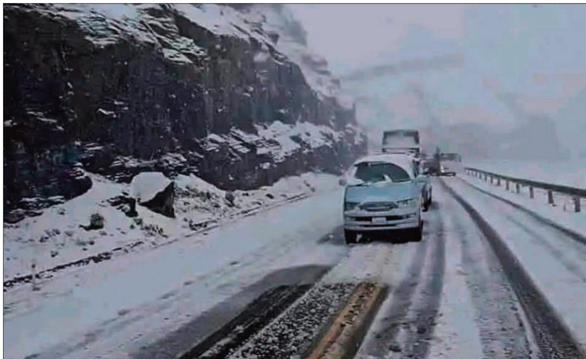
ruta. Parte del camino entre la ciudad de La Paz y el norte del departamento estuvo cubierto de nieve.
