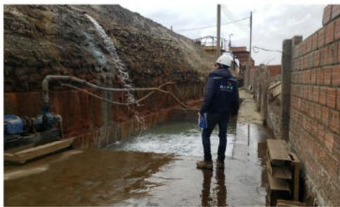
**Funcionario de la AAPS verifica las filtraciones en un dique de cola de una minera ilegal.**
