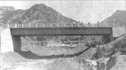
Este es el puente "Saytu", en Río Abajo
