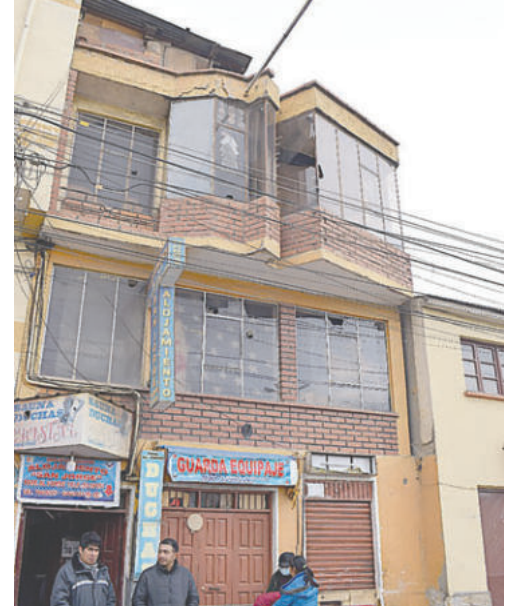
Por el conflicto, incluso algunos vidrios de viviendas fueron afectados / LA PATRIA
