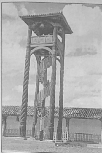
Restauración de construcciones arquitectónicas en la Vicaría de Ñuflo de Chávez.
