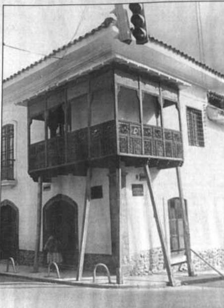
BALCON restaurado del Museo de Etnografía y Folclor ubicado entre las calles Ingavi y Jenaro Sanjines. Delante se aprecian los tres topes colocados para evitar que se repita el accidente que en 1989 provocó su caída ante el paso de un enorme camión que se trepó a la acera.
