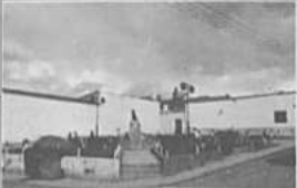
Piso. Federico Smith en la zona de San Roque, rehabilitación con la construcción de jardinería, colocada de bancas ornamentales y moderna iluminación
