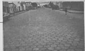
Av. Libertad (Zona San Roque) alumbrado y construcción de jardinería
