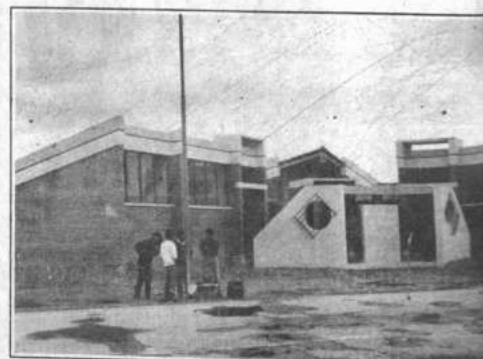
Construcción de Polifuncionales para los barrios.
