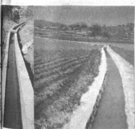
DE LOS GRANDES PROBLEMAS POR LOS QUE ATRAVIESAN LAS UNIDADES DE LAS PROVINCIAS ESTEBAN ARZE, MIQUE Y CAMPE. PRECISAMENTE LA FALTA DE AGUA PARA RIEGO Y DE USO DOMESTICO, FRENTE A ESTA REALIDAD, EL P.D.A.R. VIENE EJECUTANDO UNA SERIE DE OBRAS CON LA CONSTRUCCION DE CANALES REVERSES DE RIEGO Y CAPTACION DE AGUA POTABLE PARA USO MULTI-
