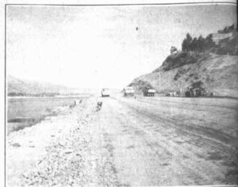
Construcción del Circuito Bolívar, en 7 kilómetros.
