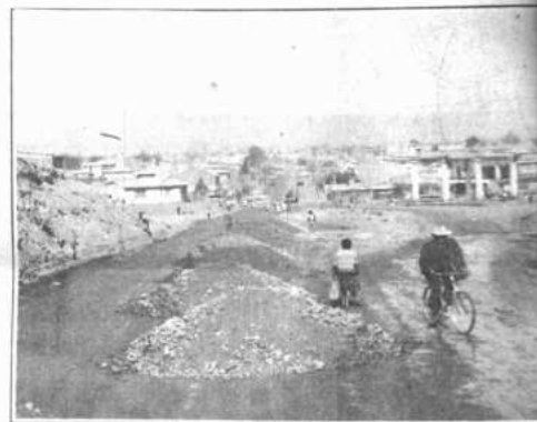
Construcción del Circuito de Tráfico Pesado.
