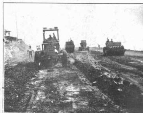
Preparación para asfaltado del Circuito hacia la Feria Internacional.
