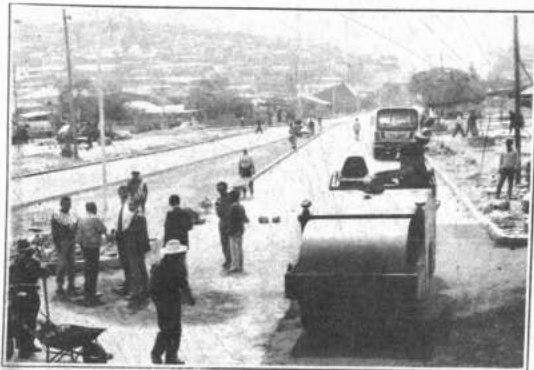
Asfaltado de calles y avenidas principales de la ciudad.
