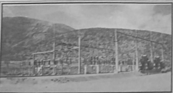
S/E en 115 KV y Transformadores de 29 MVA
