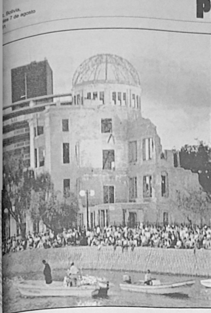
Horas de holocausto Las bombas de papel flotaron en el río frente al Parque de la Paz en Hiroshima, conmemorando la explosión de la bomba atómica, ocurrida el 6 de agosto de 1945. El edificio que se ve atrás ha sido preservado en las mismas condiciones en que quedó después de la explosión. (Hiroshima, Japón, 6 de agosto de 1991).
