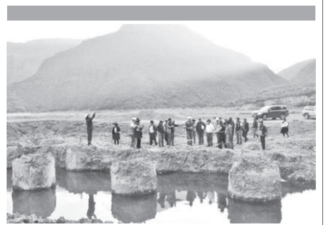
La inspección al puente Sacambaya. GADC
