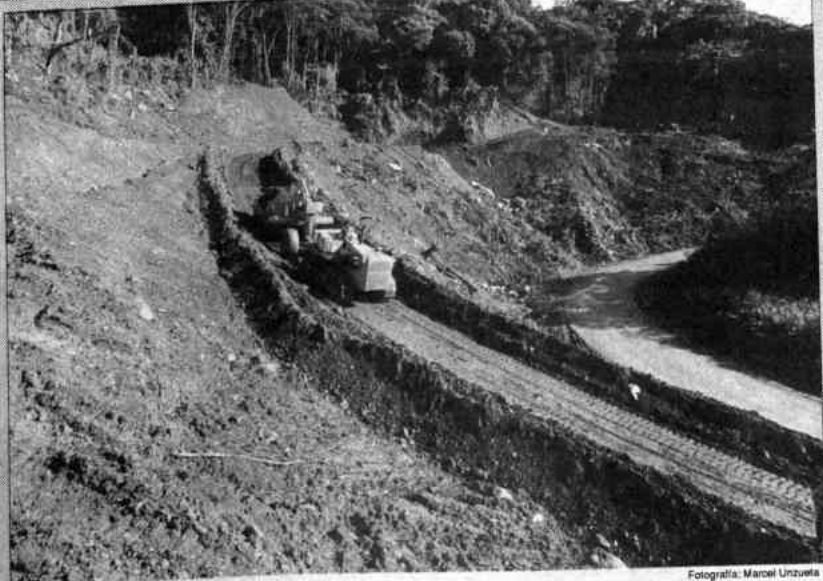
Fotografía: Marcel Urzueta Esta es la zona llamada El Sillar, en la carretera Cochabamba-Santa Cruz, en la que se construyen accesos viales. Los trabajos están a cargo de la empresa Andrade-Gutiérrez que se adjudicó la obra con un costo de 57 millones de dólares.
