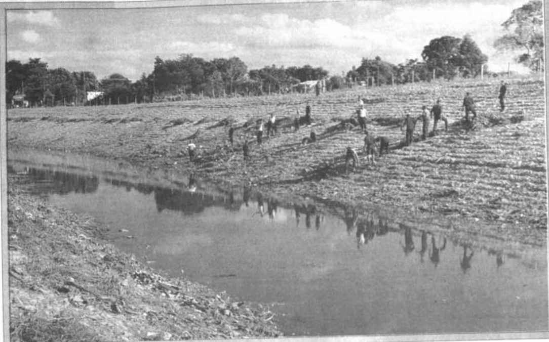
Obras contra inundaciones
