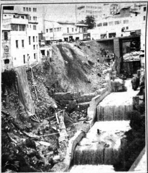
Para evitar nuevos deslizamientos en la calle Bueno por el desborde del río Choqueyapu, fueron colocados hasta ayer 150 bloques de gaviones de piedra.
