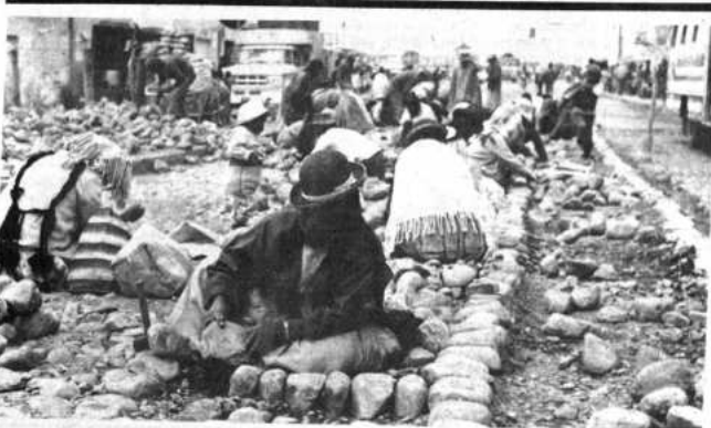
Mejoramiento urbano Algunas obras de infraestructura o de mejoramiento urbano, en la ciudad de El Alto, las realizan en su mayoría mujeres, a cambio de alimento por trabajo, proporcionados por la organización no gubernamental ADRA-OFASA.
