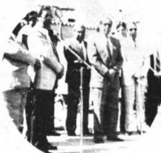
INICIAMOS LAS OBRAS DE UN MODERNO POLICONSULTORIO CBBA, junio-1990
