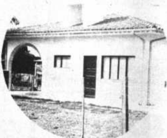
CONSTRUIMOS LA POSTA SANITA- RIA "SANTA ANA DE YACUMA" Trinidad, Junio-1990
