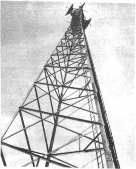
Proyecto de Telefonía Rural para los Departamentos de TARIJA, COCHABAMBA y LA PAZ, en su fase final de ejecución.
