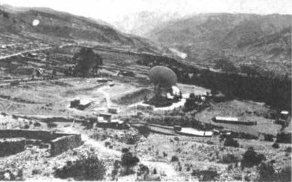
Primera Estación Terrena "TIWANACU", en servicio desde 1978.
