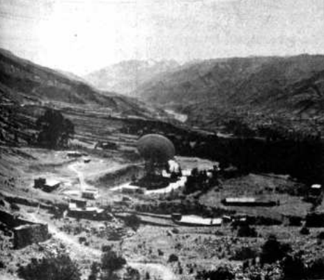
Estación Terrena "TIWANACU", en servicio desde 1978.
