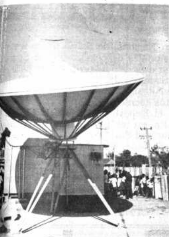
Estaciones Terrenas Remotas del Sistema Domsat, en fase final de ejecución.
