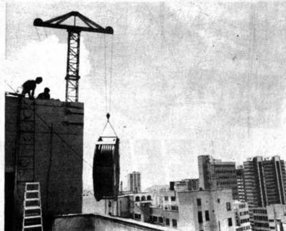
Trabajos de instalación en el Proyecto RED TRONCAL DIGITAL (LA PAZ-COCHABAMBA-SANTA CRUZ).
