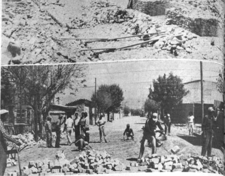
Obras Con financiamiento de 1.7 millones de dólares se realizan los trabajos de encausamiento de la Guadalupe. Por otra parte, la Alcaldía Municipal también lleva a cabo trabajos de enlosado en algunas marginales de la ciudad de Tarija con el apoyo financiero del Fondo Social de Emergencia. En las fotos se observan, panorámicas de estas obras.
