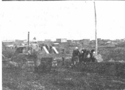
Maquinaria pesada de la Corporación Regional de Desarrollo de La Paz (CORDEPAZ) nivela las calles y avenidas de Villa Ingenio, Distrito I. Para esos trabajos, los vecinos corren con los gastos del combustible (diesel). Aportan treinta litros de diesel para el trabajo de una hora.
