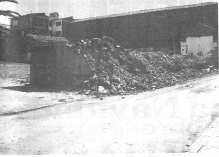
Las autoridades municipales están concluyendo la demolición del antiguo edificio de la Cárcel Pública que se levantaba en las afueras de la Plaza "Luis de Fuentes", lugar en el cual funcionaba el Cabildo de la época colonial. El lugar, que se va convirtiendo en una plaza de esparcimiento en el centro de la ciudad, se pretende la construcción de un Teatro Municipal, fin para el cual se ha constituido un Comité con representantes de diferentes sectores.
