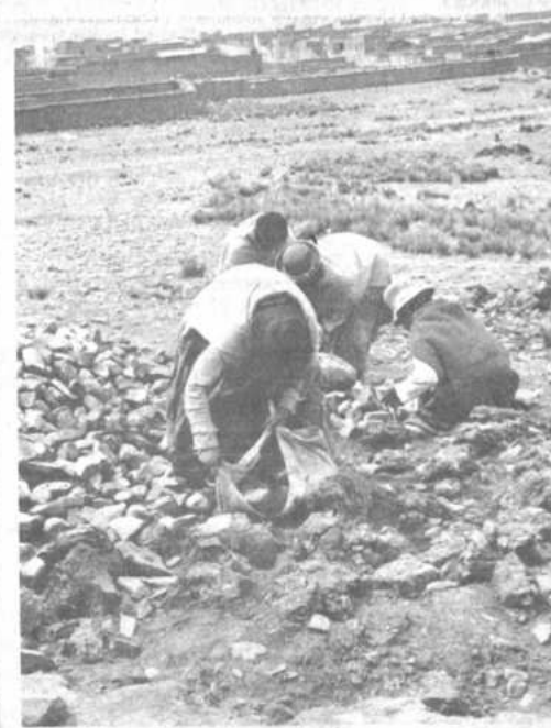
Trabajos de empedrado
