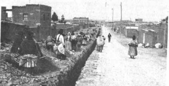
Amas de casa y desocupados en pleno trabajo del rellenado de las zanjas de alcantarillado de la Zona de Alto Lima III, del sector norte de la ciudad de El Alto.
