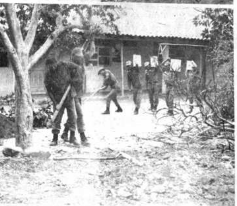
Como parte del plan de actividades de Acción Cívica que se llevan a cabo en la ciudad de Camiri en apoyo a la población en general y en particular a la niñez, efectivos de la Cuarta División del Ejército, realizan trabajos de refacción total del kindergarten Graciela de Delgadillo de esta ciudad.
