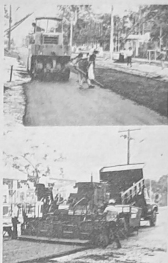
Pavimentación de avenida
