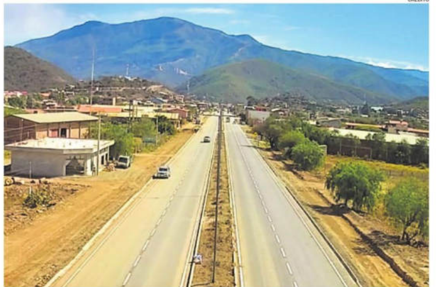
Vista panorámica del tramo entregado
