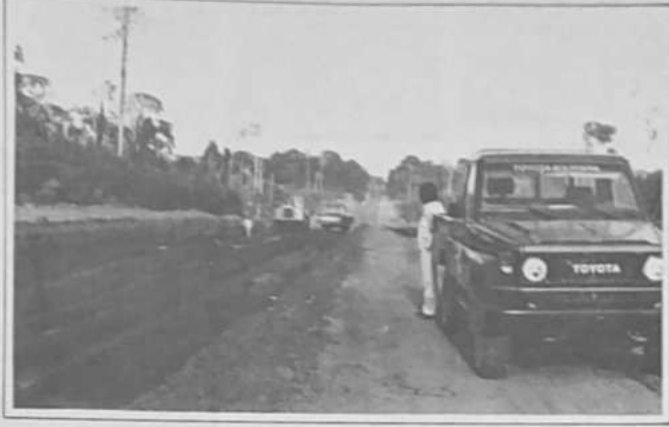
Construcción de Carretera
